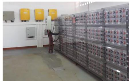
Mini Grid através duma Central Fotovoltaica de 10 KW em Mucuale, Nampula
